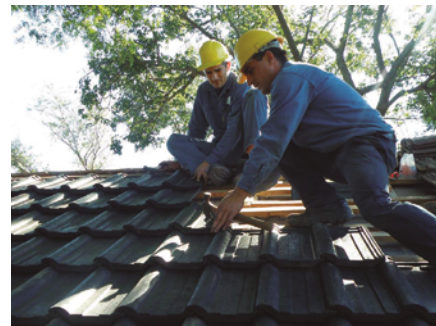
Montaje de cubierta con tejas
