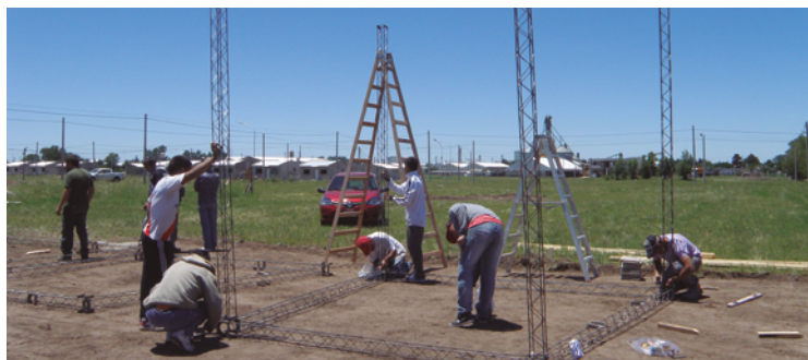
Proceso de montaje de sistema UMA Proyecto Detem Río Cuarto
